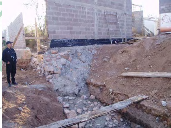
(foto 17) Obras de construcción en Real del Arco su propósito: evitar inundaciones.
