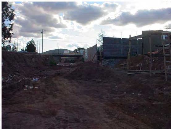
(foto 16) Arroyo Ave. Tecnológico al fondo el puente de acceso a Real del Arco
