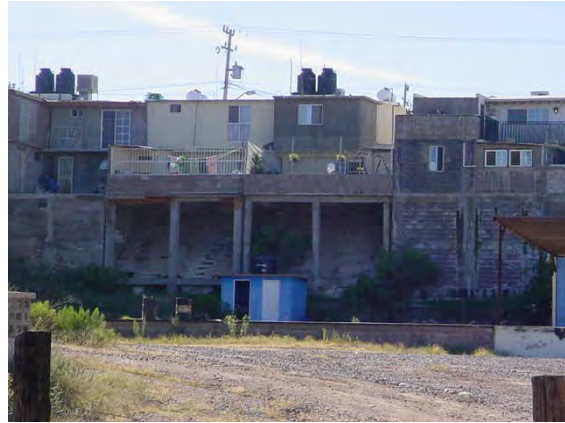
(foto15) Los pilares permiten nivelar fachadas por avenida tecnológico (Vista posterior)
