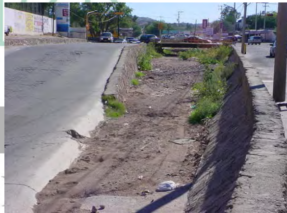
(foto12) Arroyo de la Ave. Tecnológico que conecta con el arroyo los Nogales
