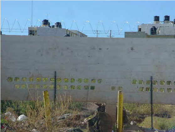
(foto 14) Desarenador en Real del Arco
