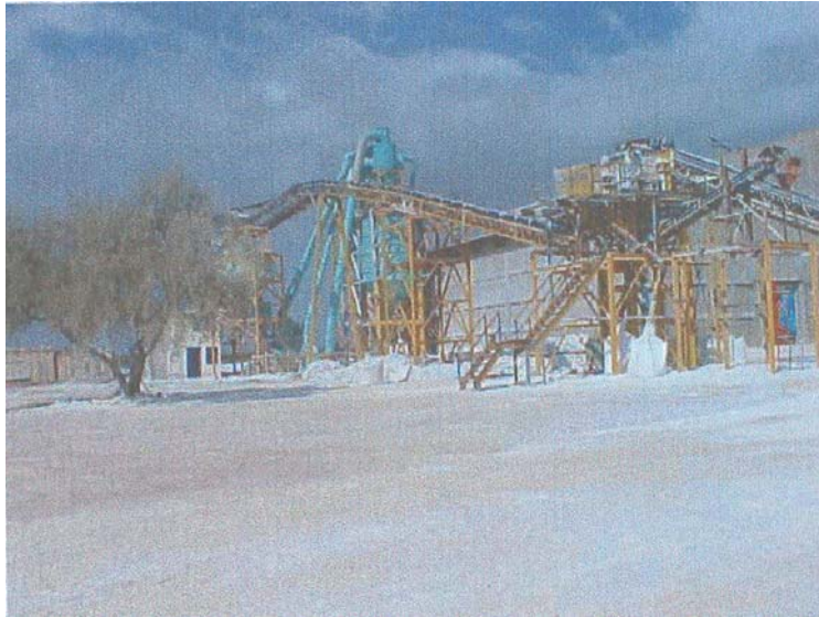
Figura 8. Instalaciones de la Planta de la minera “Wallas”
